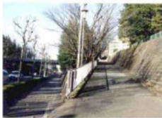
・バス停と住宅地を繋ぐスロープ
