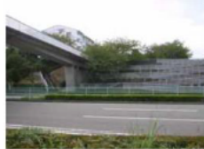
・長い急勾配スロープ(勾配1/10)
